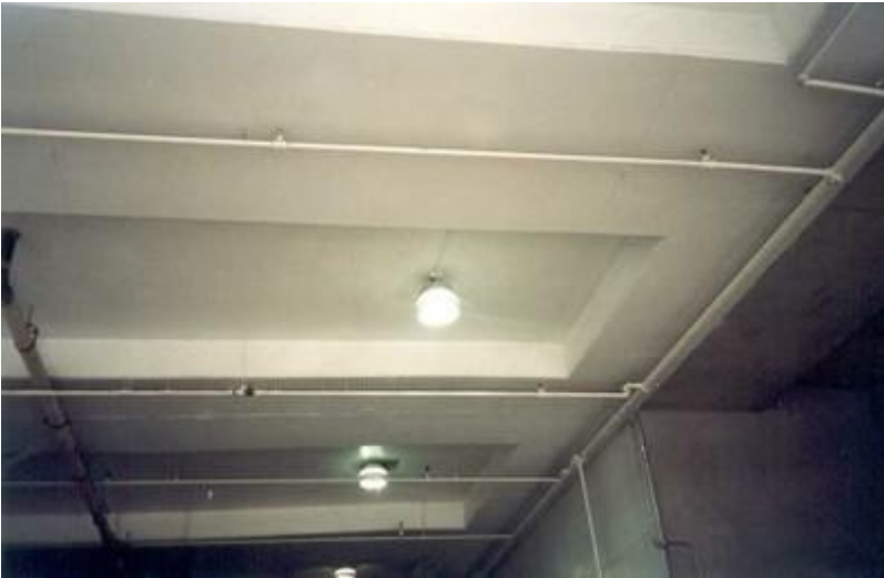
Slab band system, Canada (S. Brzev)
