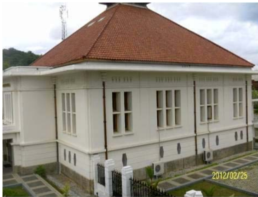
Clay tile roof covering, Padang, Indonesia (J. Bothara)
