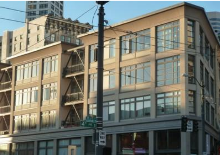
Braced frame (Chevron braces), Seattle, USA (S. Brzev)
