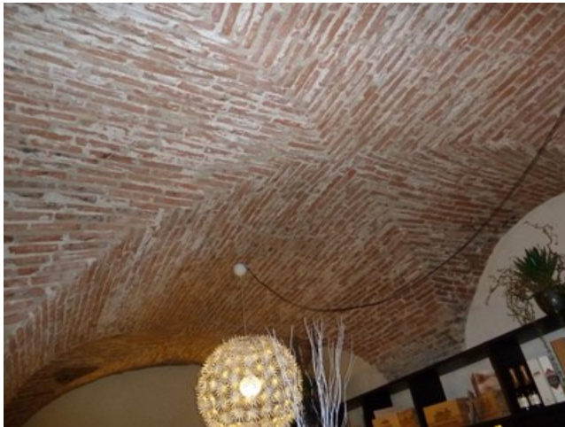
Brick masonry double vault, Italy (S. Brzev)
