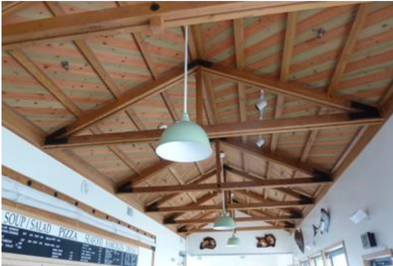
Wooden roof truss, California, USA (S. Brzev)
