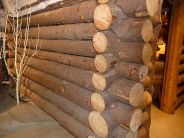
Log wood wall intersection, USA (S. Brzev)
