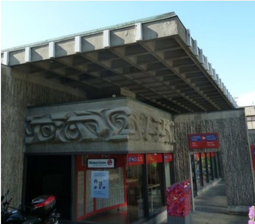
Reinforced concrete waffle slab, Canada (S. Brzev)
