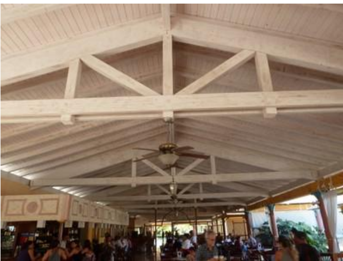
Wooden roof truss structure, Cuba (S. Brzev)
