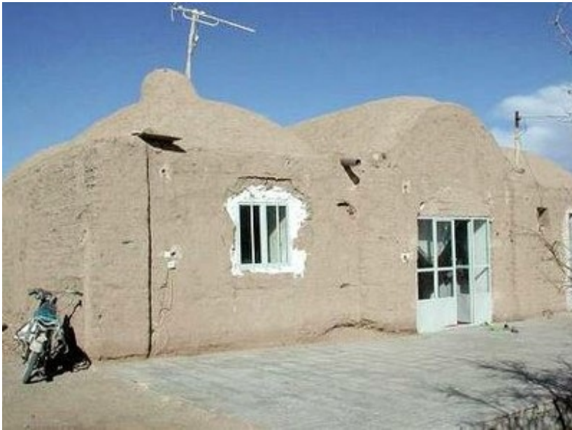
Earthen masonry domes, Iran (F. Naeim)
