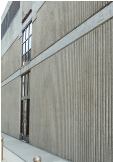
Reinforced concrete wall panels, USA (S. Brzez)
