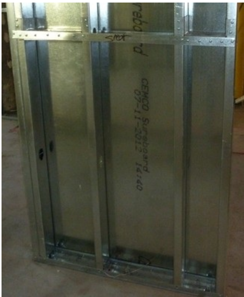
Cold-formed steel framing detail, USA (S. Brzev)
