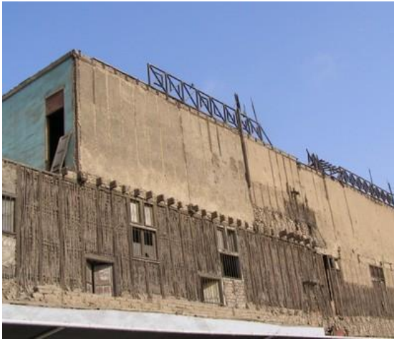
Walls, quincha construction, Peru (S. Brzev)
