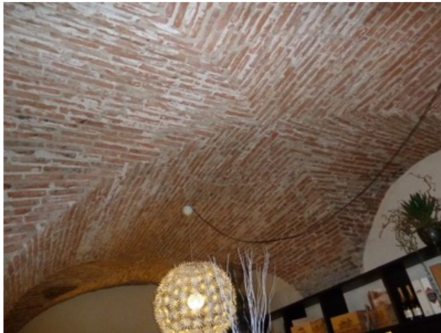
Brick masonry double vault, Italy (S. Brzev)
