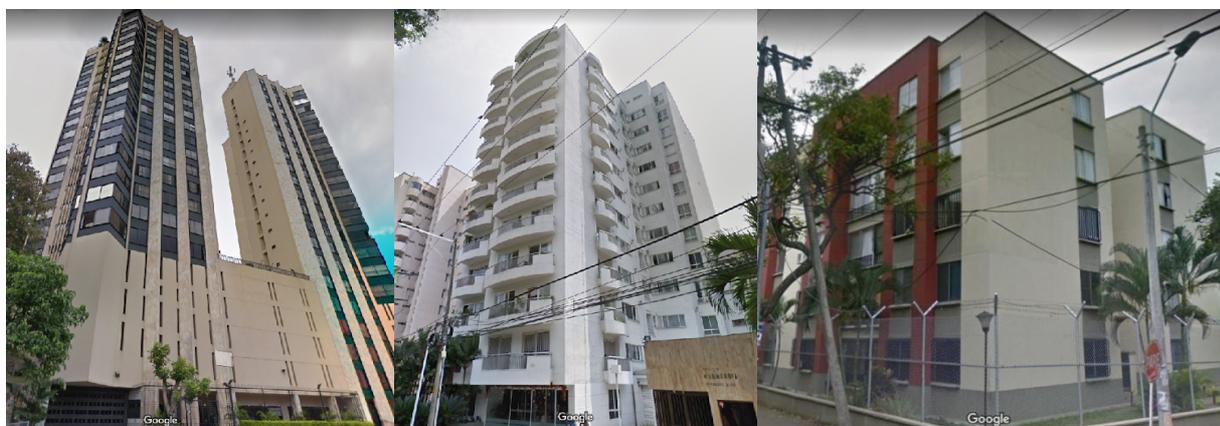
**Figura 20. Edificios de muros colados en sitio y prefabricados de concreto reforzado en el Barrio Buenos Aires y Torres Comfandi. Tomados de Google Maps (2020) y OSSO (2017).**
