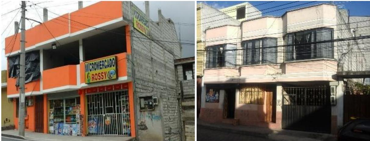
**Figura 9. Configuraciones de pórticos de concreto confinando muros de mampostería. Fuente: Informe Fase 1, Proyecto SARA (EPN, 2016).**
