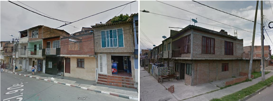
**Figura 18. Casas de mampostería semiconfinada, carentes de vigas de amarre y con muros excesivamente largos o en los barrios Lleras Camargo y El Jarillón respectivamente. Tomadas de: Google Maps (2020).**
