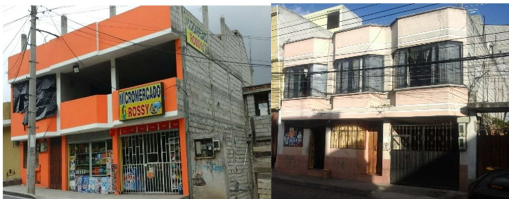
Figura 19. Configuraciones de pórticos de concreto confinando muros de mampostería. Tomado de: Informe Fase 1, Proyecto Sara (EPN, 2016).
