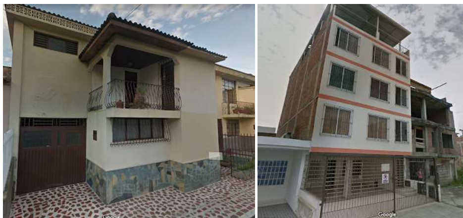
Figura 21. Casas de mampostería confinada cumpliendo e incumpliendo la normativa NSR-10 en los barrios San Fernando y El Caney, respectivamente. Tomadas de: Google Maps (2020).
